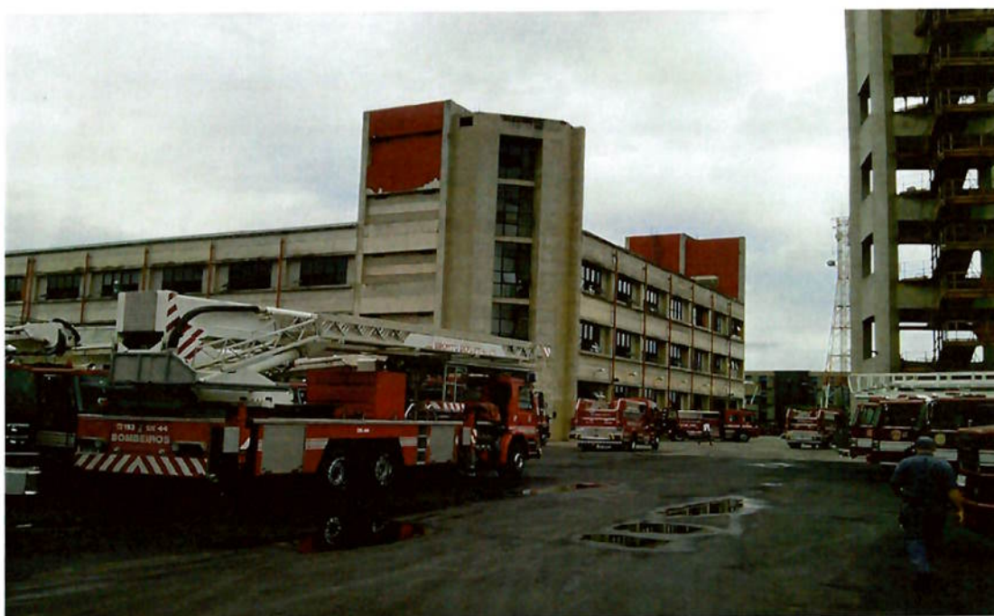
FIGURA 18 – Centro de Suprimento e Manutenção de Materiais Operacionais de Bombeiro (CSM/MOpB)
